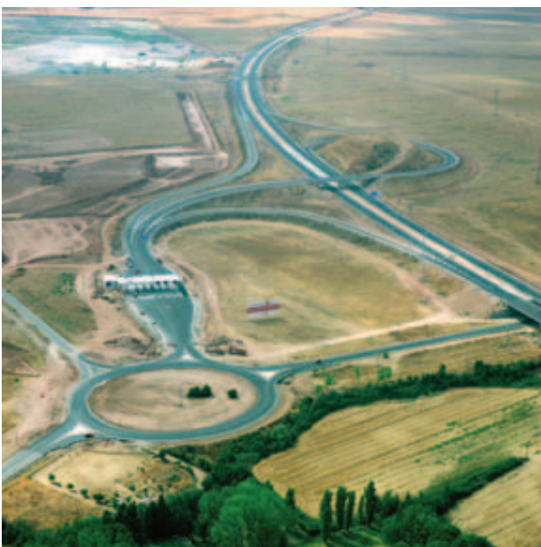
Autopista Radial 2 en Madrid
