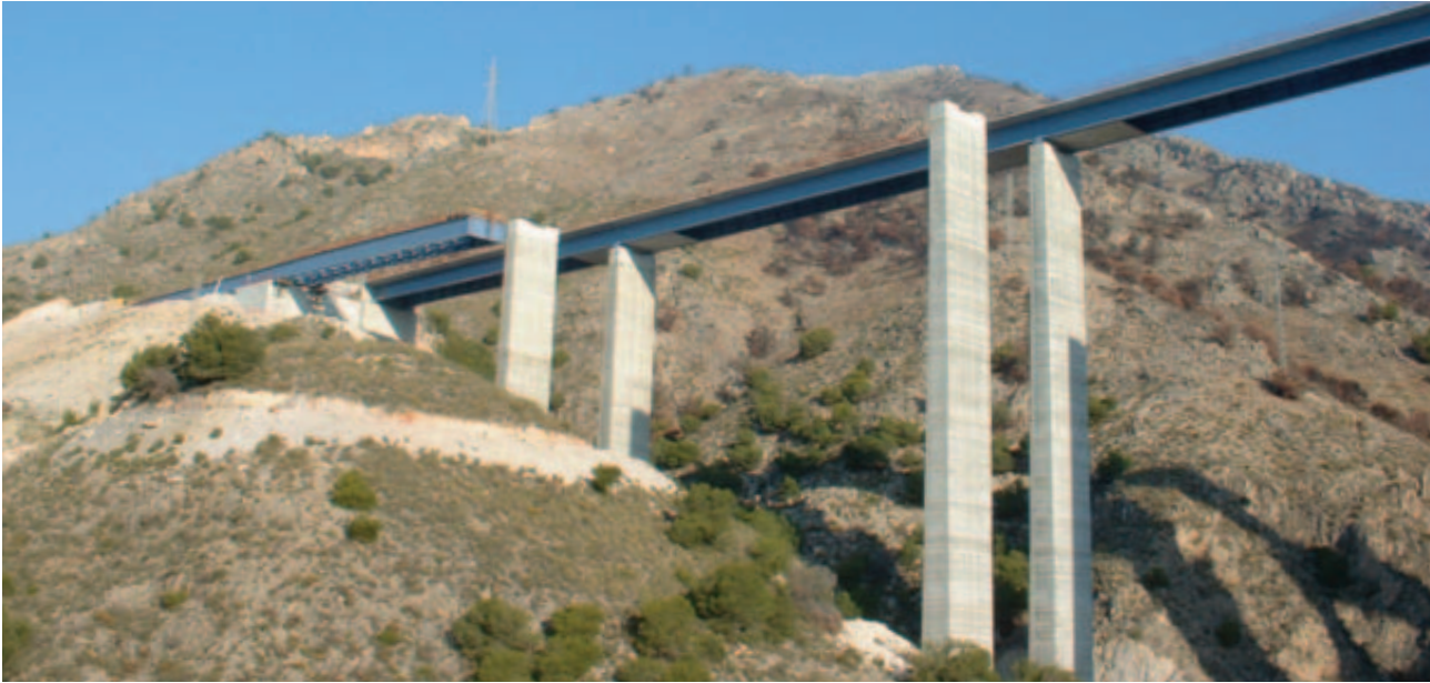
Viaducto Miel en Nerja (Málaga)
