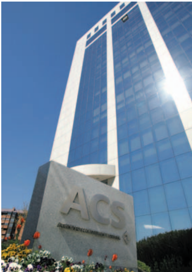
Edificio de la sede corporativa de ACS
