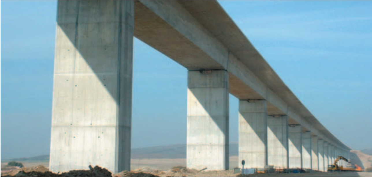
Tramo AVE Puente Genil (Córdoba)
