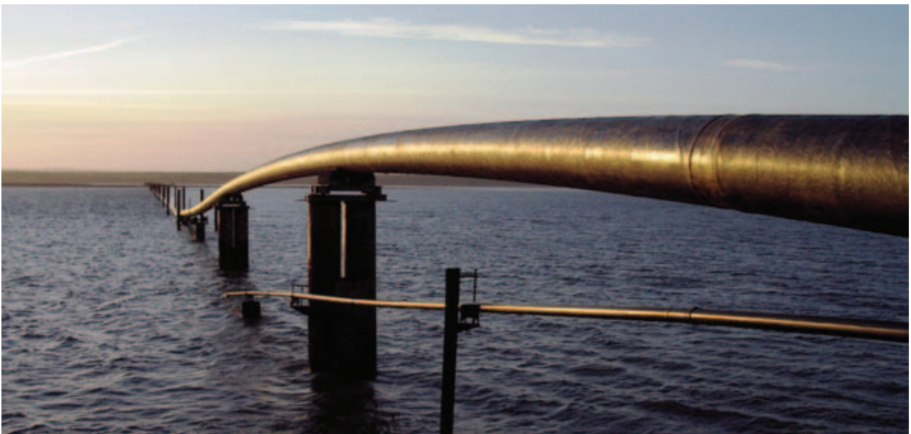
Gasoducto Sines-Setúbal (Portugal)
