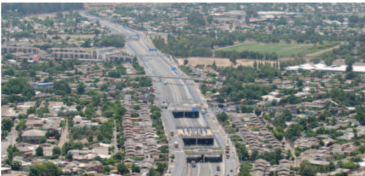
Autopista Central (Sistema urbano Norte-Sur) en Chile
