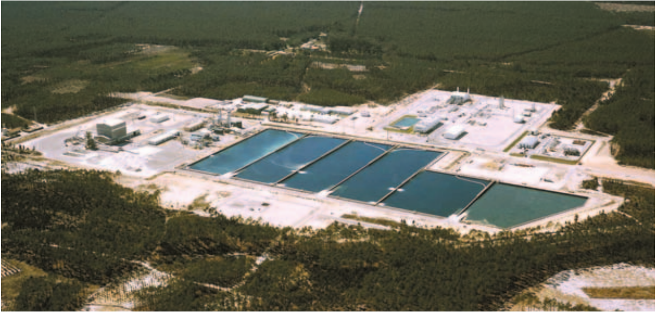
Almacenaje subterráneo de gas natural, Carrizo (Portugal)
