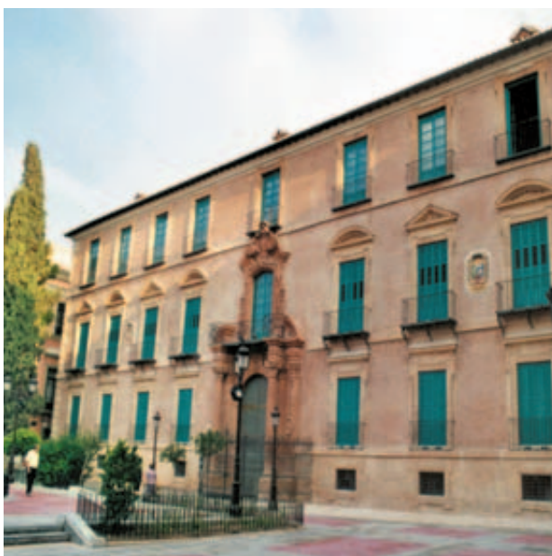
Rehabilitación Palacio Episcopal de Murcia
